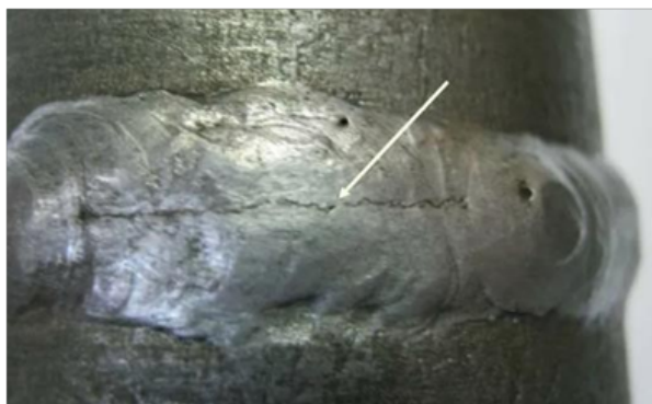
Рисунок 2.1. Трещина сварного шва
